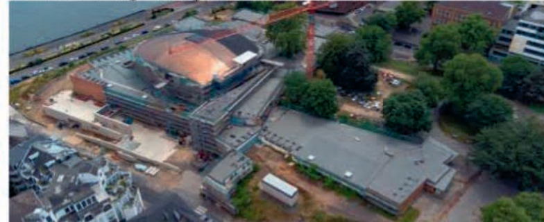
6.320 m² Flachdächer bleiben nach der Luxus-Sanierung ohne Begrünung.
